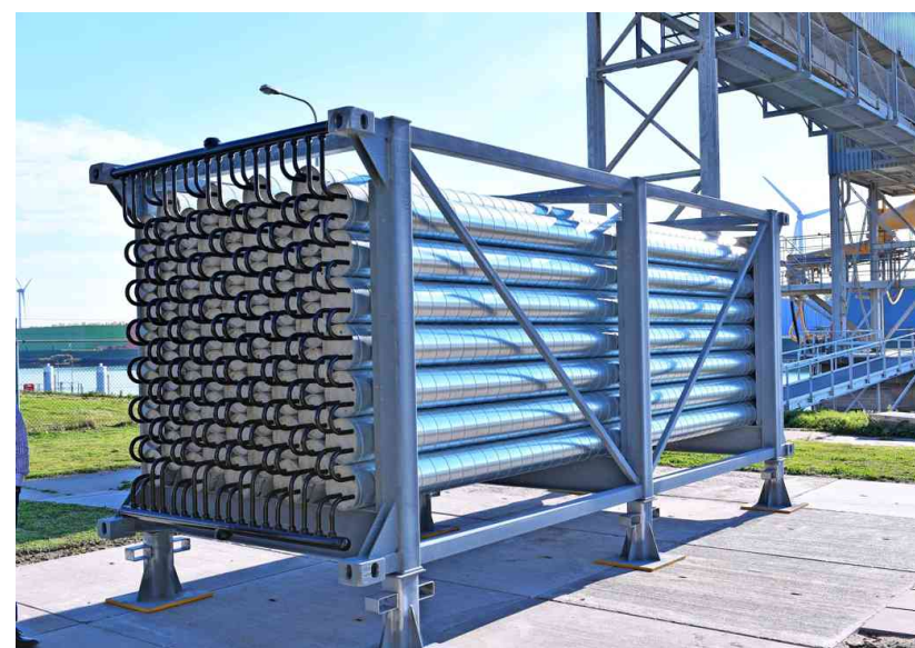
Baustein für die Wärmewende: Speicher mit Betonkernen von Energy Nest
