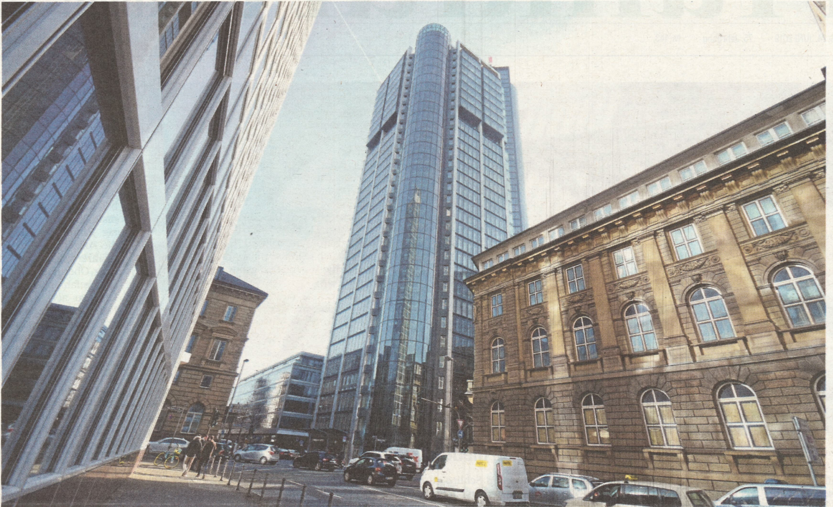
Die 31 Stockwerke des Hochhauses Eurotheum in der Neuen Mainzer Straße werden komplett mit Abwärme von Servern beheizt.
