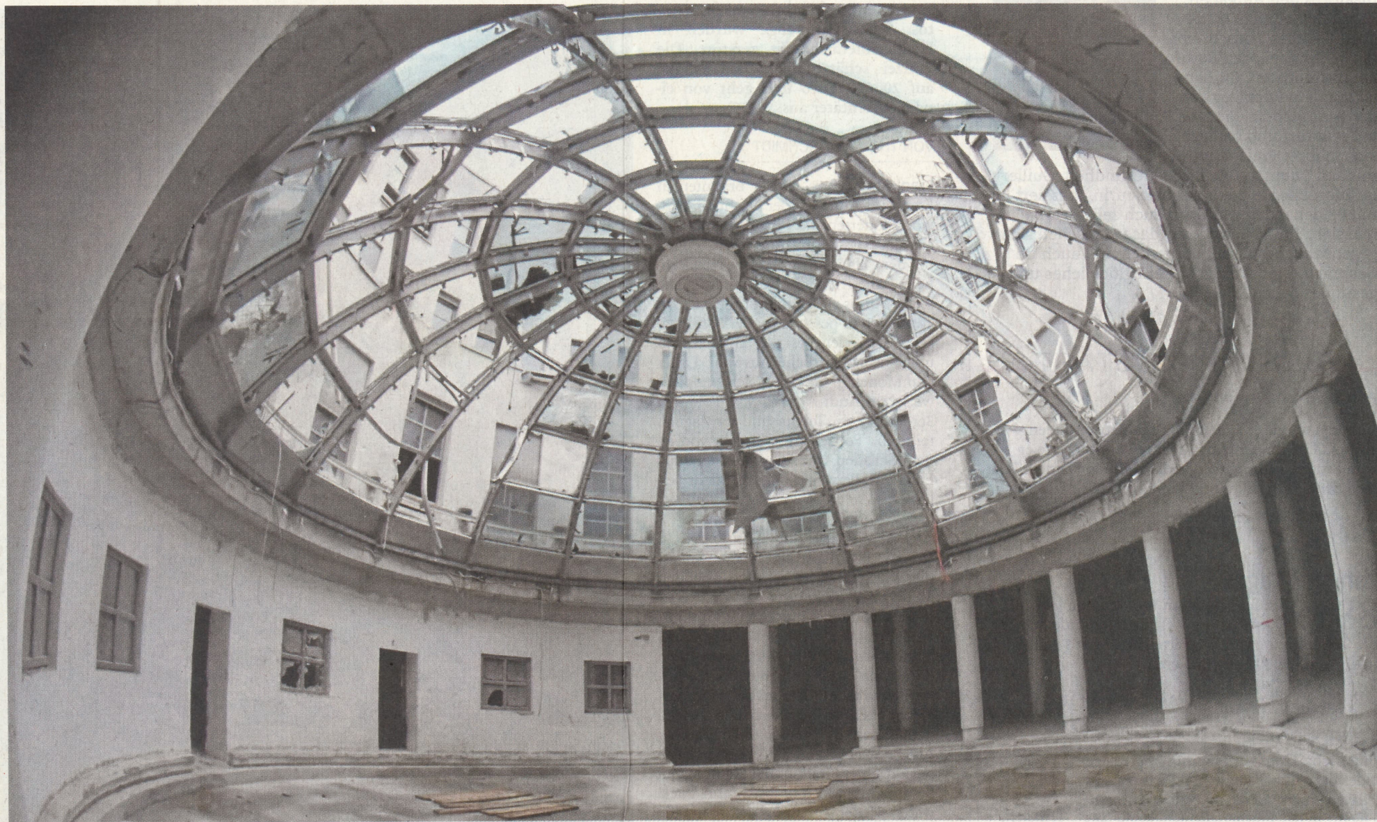
Die Glaskuppel im Inneren der ehemaligen Oberpostdirektion soll verschwinden. Dort entsteht ein Innenhof mit Arkadengängen, die zu den Wohnungen führen. Fotos: Rainer Ruffer
