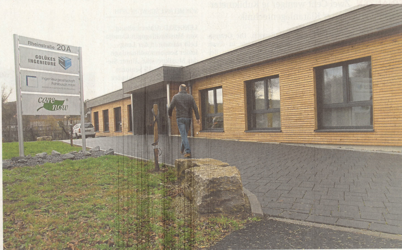
Seit 2014 sitzt das Ingenieurbüro Golükes in Nieder-Ramstadt. Mit dem Umzug an diesen Firmensitz ergab sich die Möglichkeit, die innovative Abwassernutzung auch im eigenen Haus einzusetzen.
